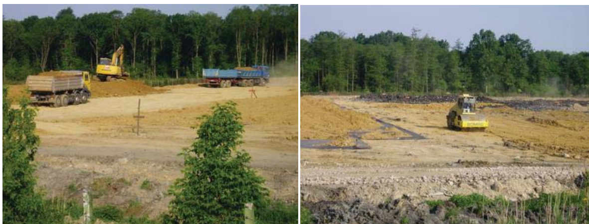
Slika 9. Radovi na sanaciji odlagališta Kutina (slike preuzete sa službene stranice Moslavina d.o.o., 2013.).
